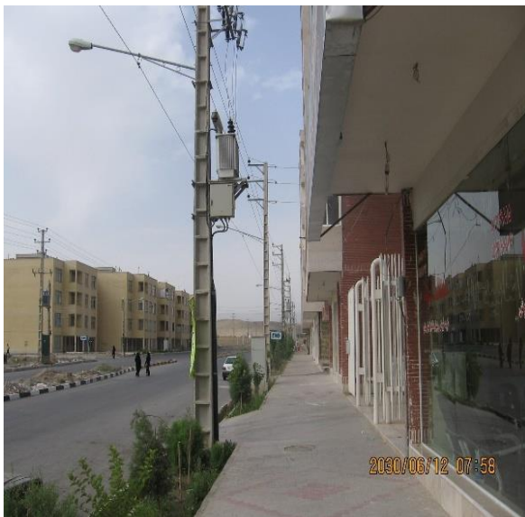
شکل ۱۰- تصویر پست هوایی یکپارچه نصب شده در شبکه
