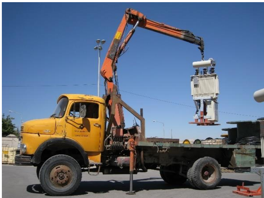
شکل ۲- نحوه حمل پست هوایی یکپارچه مونتاژ شده از انبار به محل نصب
