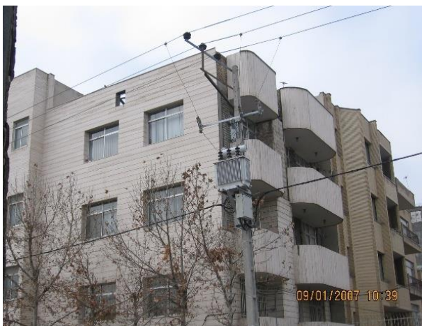
شکل ۵- تصاویر پست هوایی یکپارچه نصب شده در شبکه
