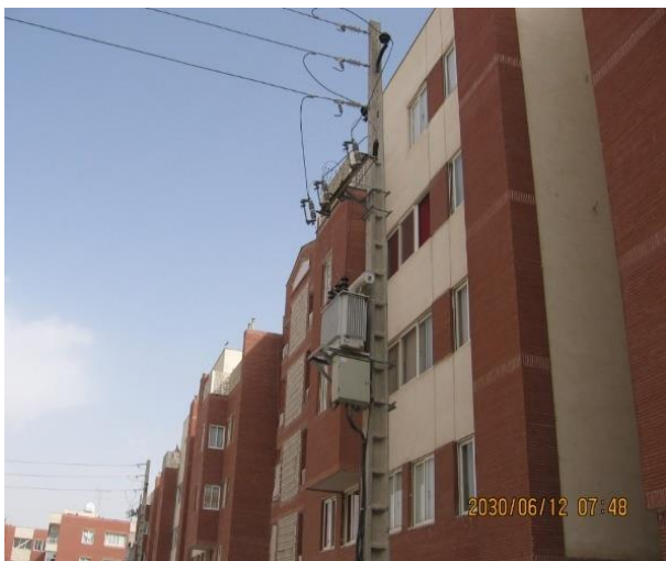
شکل ۴- تصاویر نمونه از محل نصب پست هوایی یکپارچه
