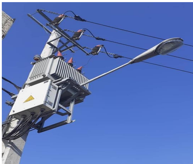
شکل ۱- تصویر پست هوایی یکپارچه مونتاژ شده در انبار و نصب شده در شبکه
