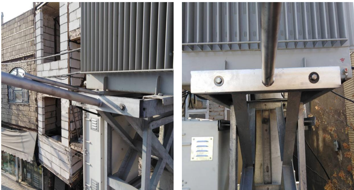
شکل ۳۷ تصاویری نمونه از موارد اجرا شده
