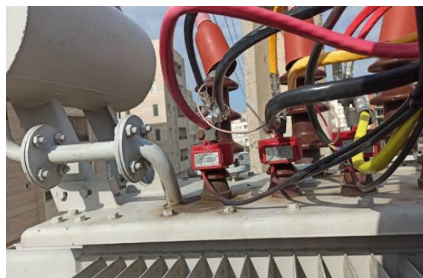
شکل ۲۰- نمونه نصب ترانسفورماتور اندازه‌گیری جریان پوشینگی روی ترانسفورماتور در پست هوایی یکپارچه
