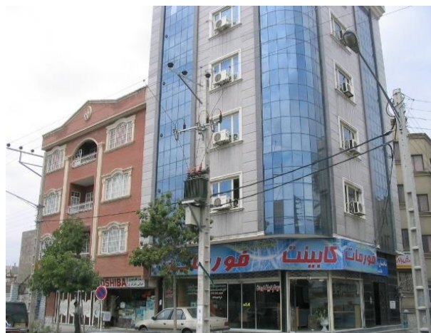
شکل ۵- تصاویر پست هوایی یکپارچه نصب شده در شبکه
