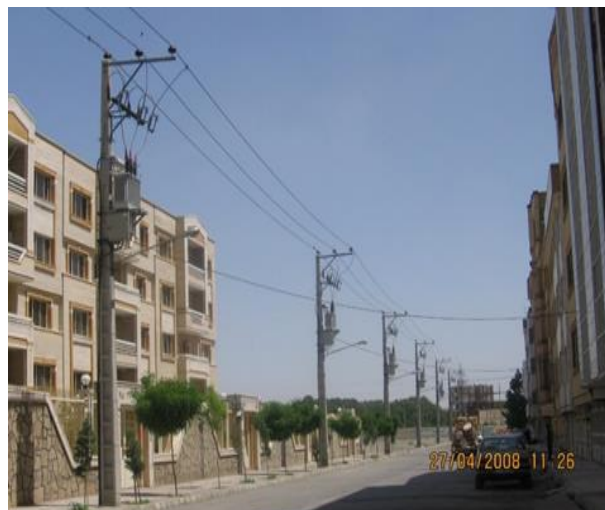
شکل ۴- تصاویر نمونه از محل نصب پست هوایی یکپارچه
